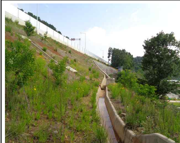
위 치 상부 현 황 전경
